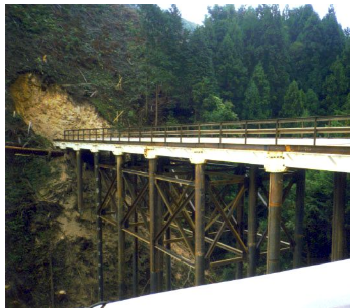
写真1 鳥取県西部地震に耐えた仮栈橋
