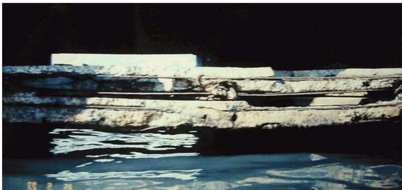
塩害劣化した崩壊寸前の RC 梁です。
