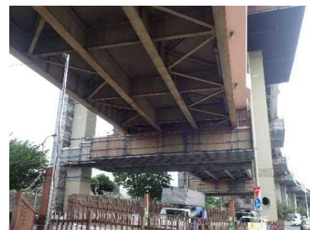
写真3 施工現場外観
