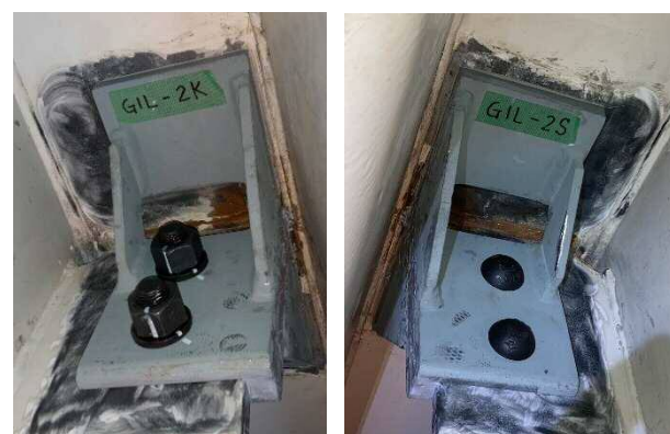
図-6 施工完了状況
