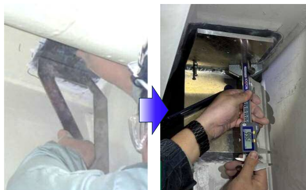
図-4 縦断勾配の計測方法の改善
