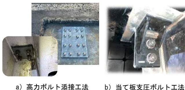
図-2 補強方法の事例
