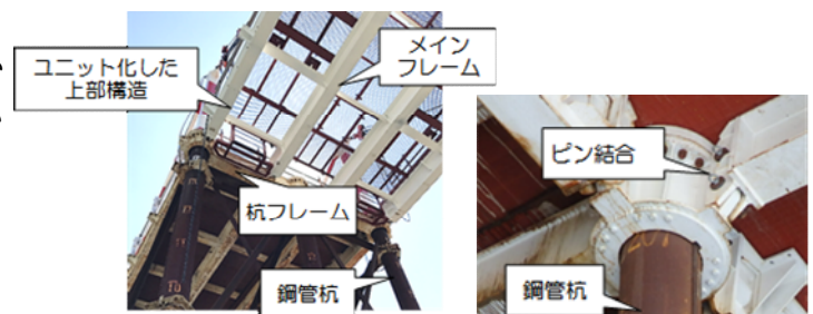
図1 鋼管杭を用いた仮栈橋(LIBRA工法)
