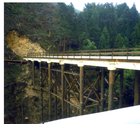
写真1 鳥取県西部地震に耐えた仮栈橋
