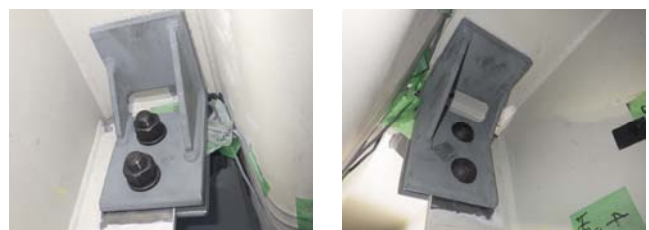
図7 試験施工写真
