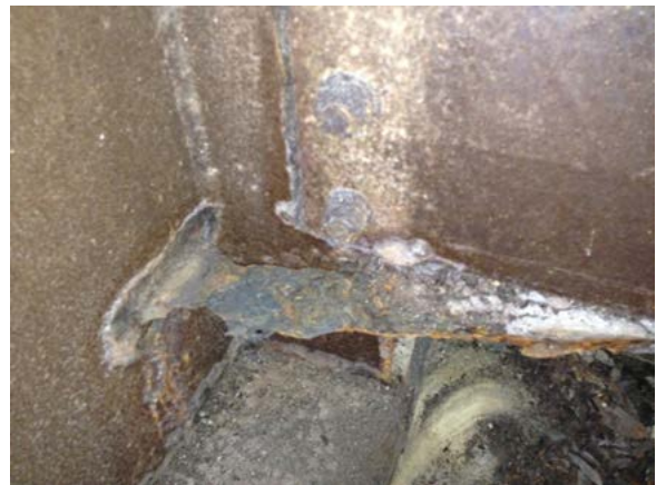
写真4 桁端部状況写真(端対傾構, 下フランジ)
