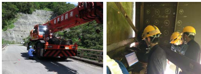
写真-1 荷重載荷試験状況
