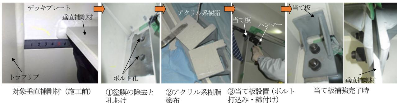
図-21 施工対象補剛材と当て板補強状況
