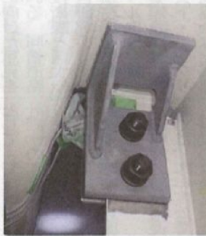
KMリフト施工例
