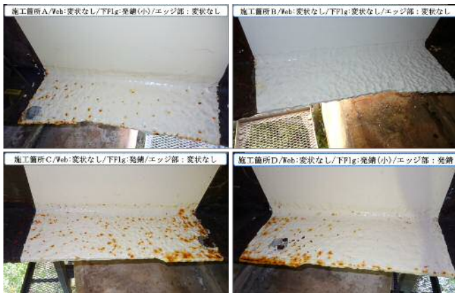
写真-3 実橋梁暴露試験状況
